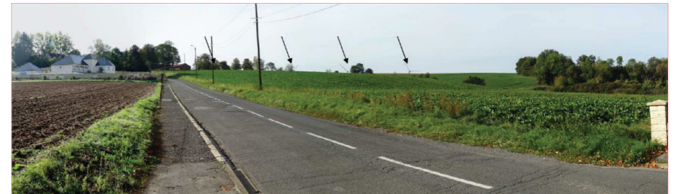
Depuis la RD68 – La briqueterie
