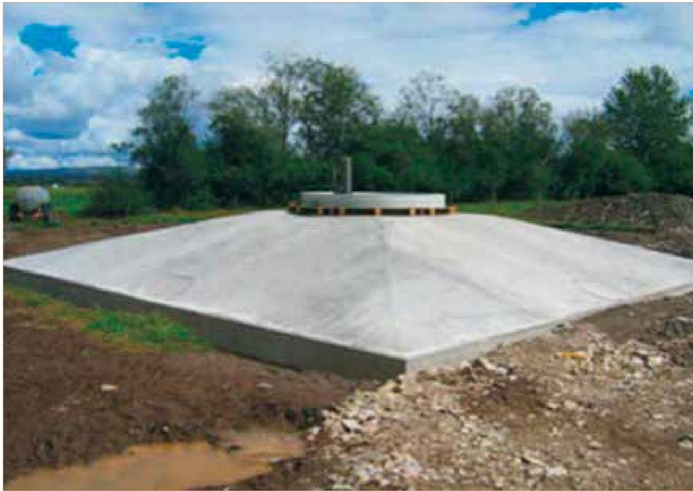
Exemple de massif de béton armé
