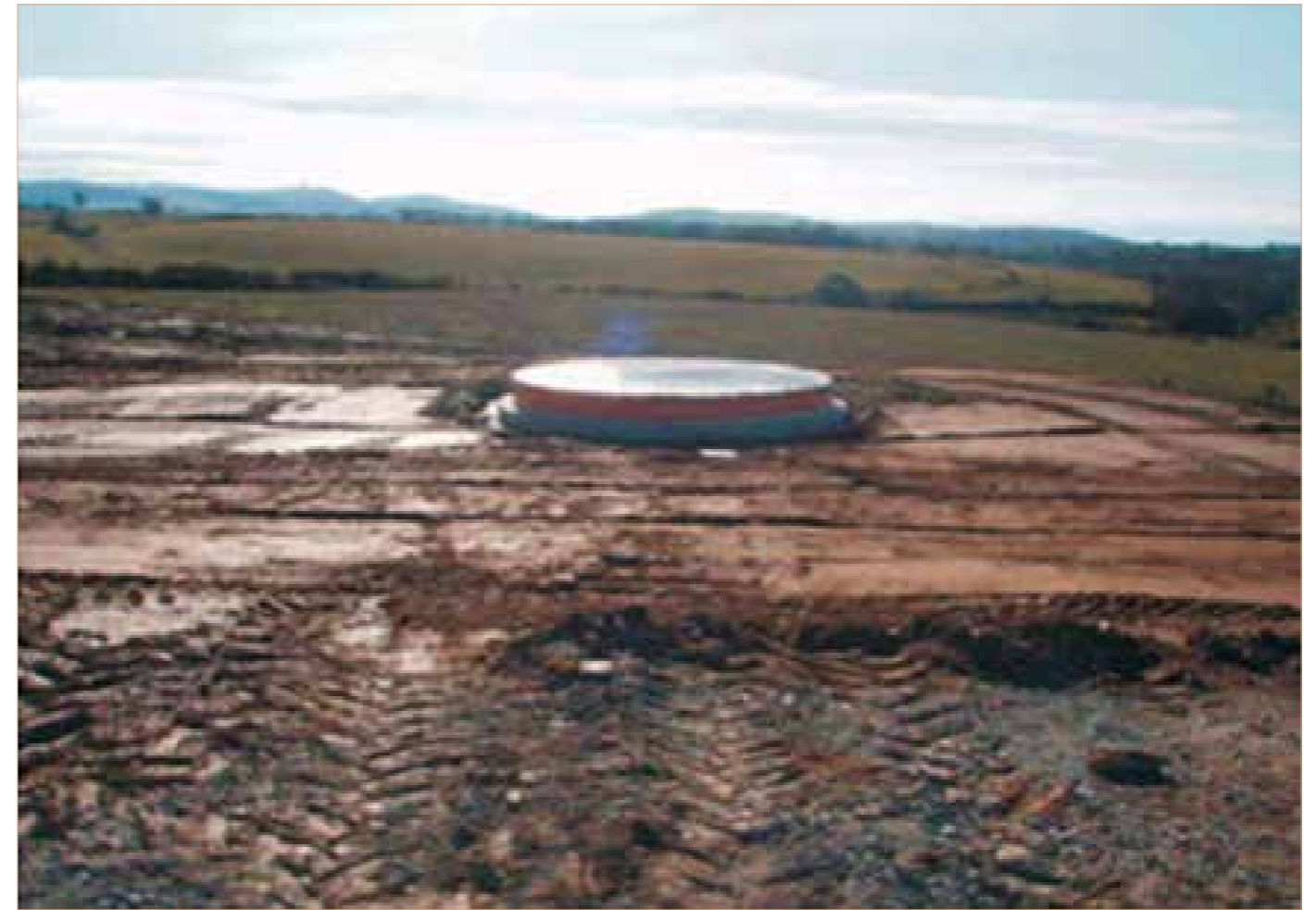
Etat final après remblaiement
